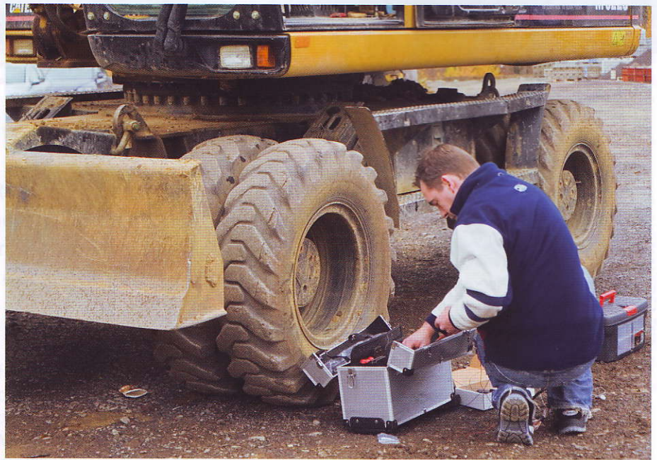
Das System wird durch geschultes Fachpersonal in die Baumaschinen eingebaut.
